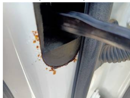
Porte avant gauche (Autre Défaut)
